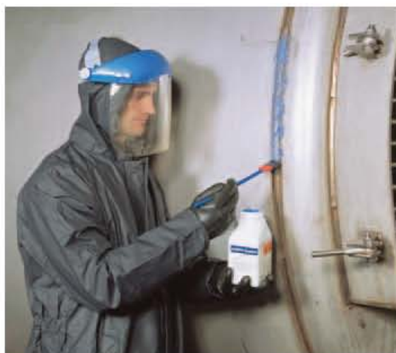
Нанесение пасты Avesta BlueOne™ 130 – с помощью кисти. Самая Безопасная Технология
