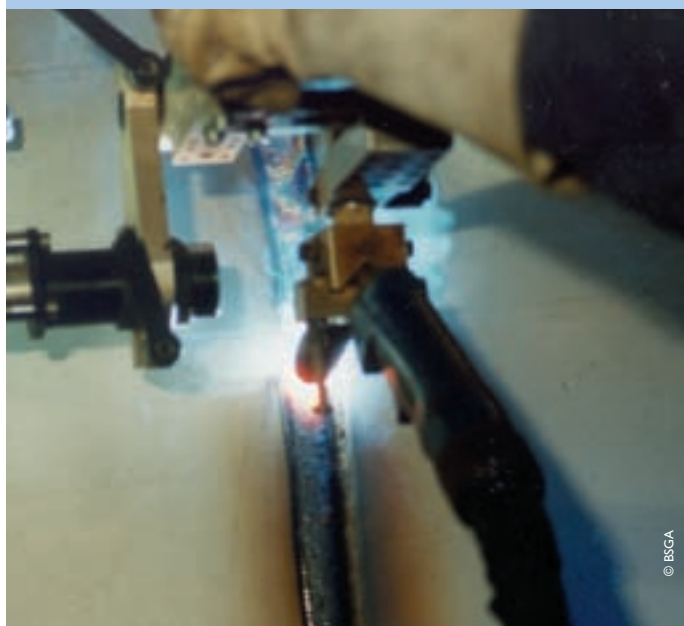
Механизированный процесс сварки с использованием BÖHLER EAS 4 PW-FD
